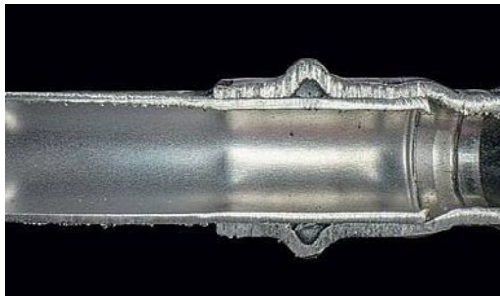
Nieodgratowane końcówki rur łatwo zdiagnozować robiąc przekrój wybranego połączenia
