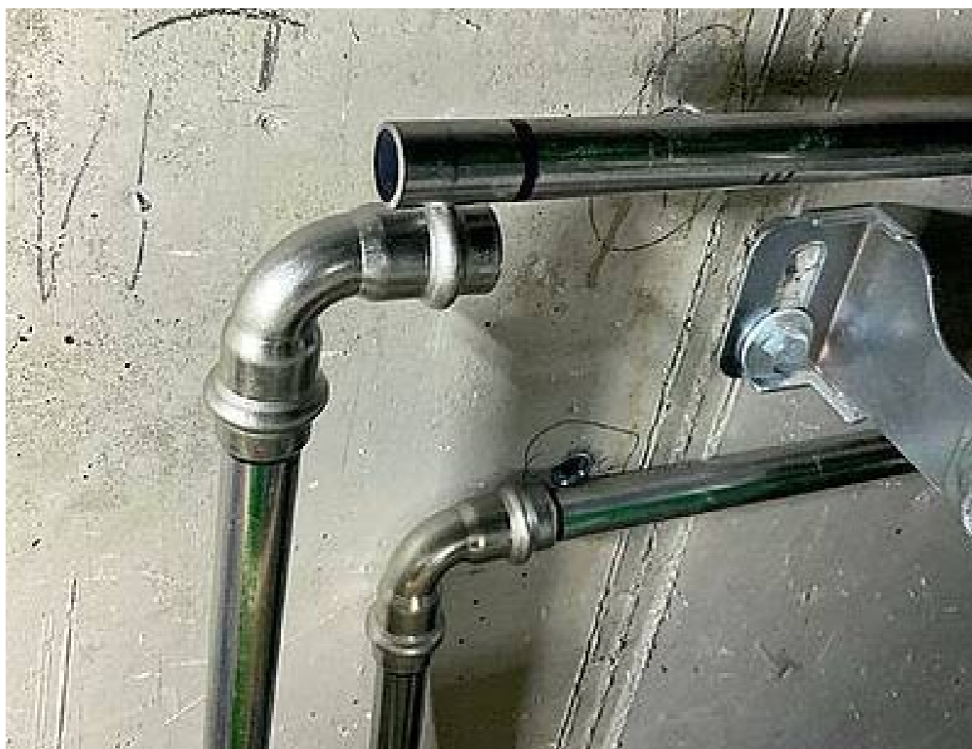
Ogratowane końce rur są widoczne i bezpieczne dla uszczelnień
