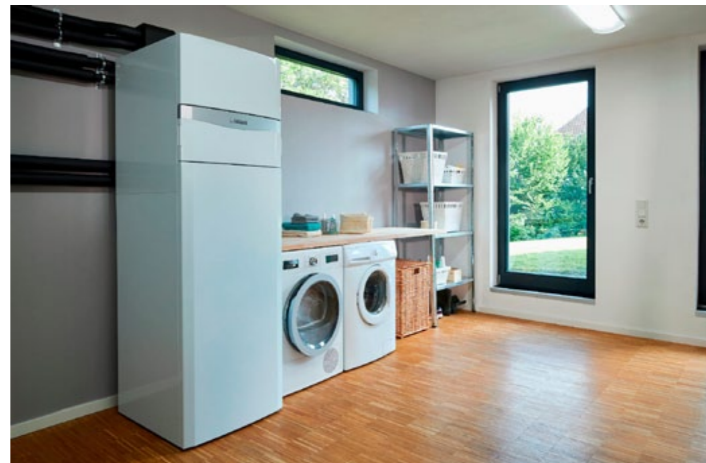
Jednostka wewnętrzna aroTHERM plus z zasobnikiem
