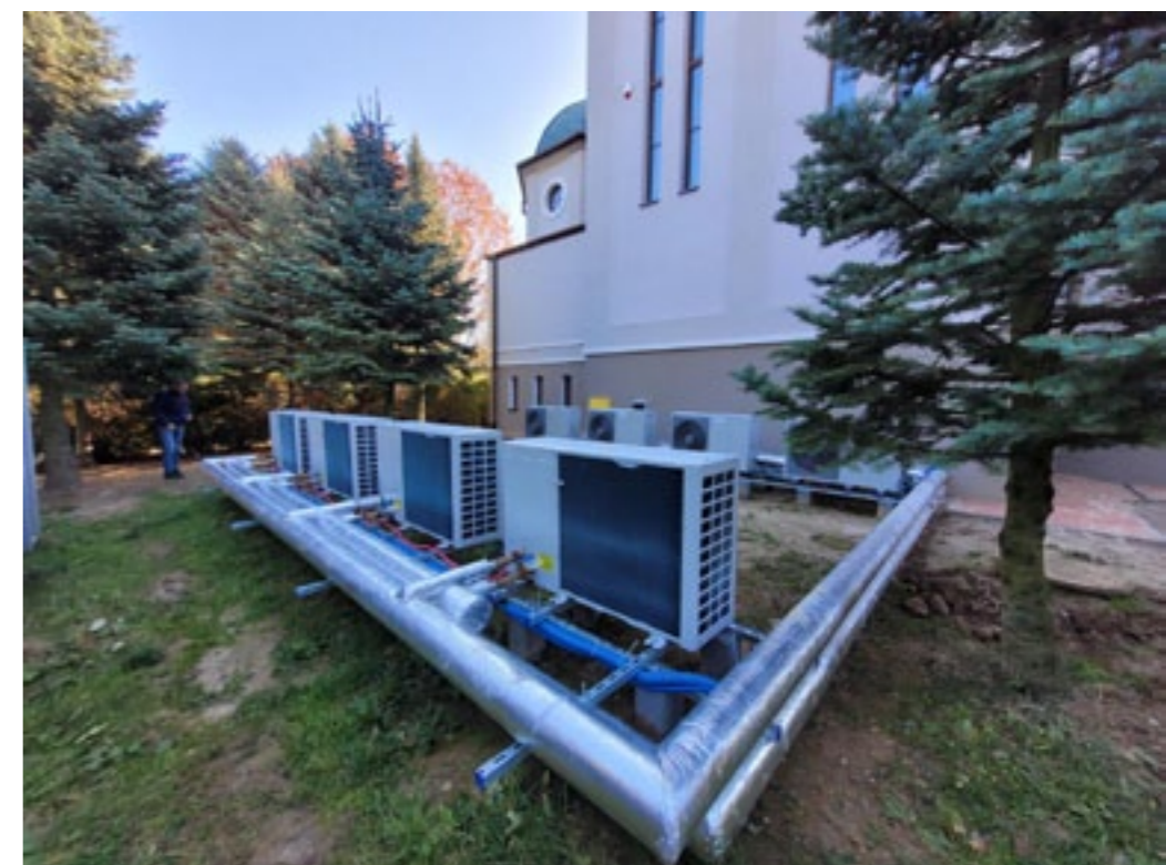
Kaskada pomp ciepła Modena
