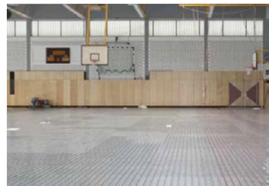
System Roth ogrzewania podłogowego w hali sportowej
