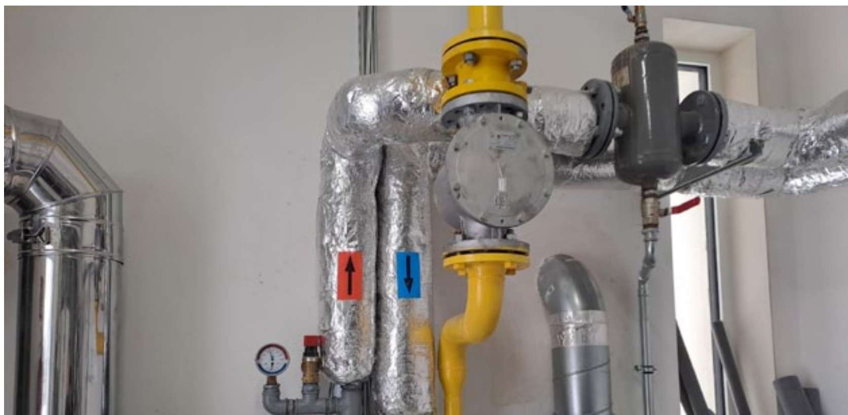
Filtr gazu serii 70600 w instalacji zasilania gazu
