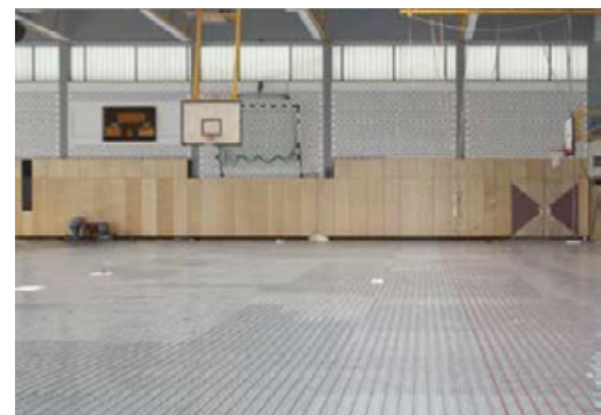
System Roth ogrzewania podłogowego w hali sportowej
