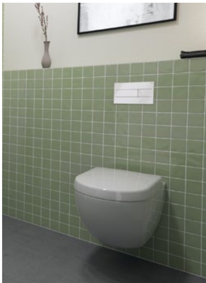
Do montażu miski WC zastosowano stelaż Prevista oraz przycisk uruchamiający Visign for More 201
