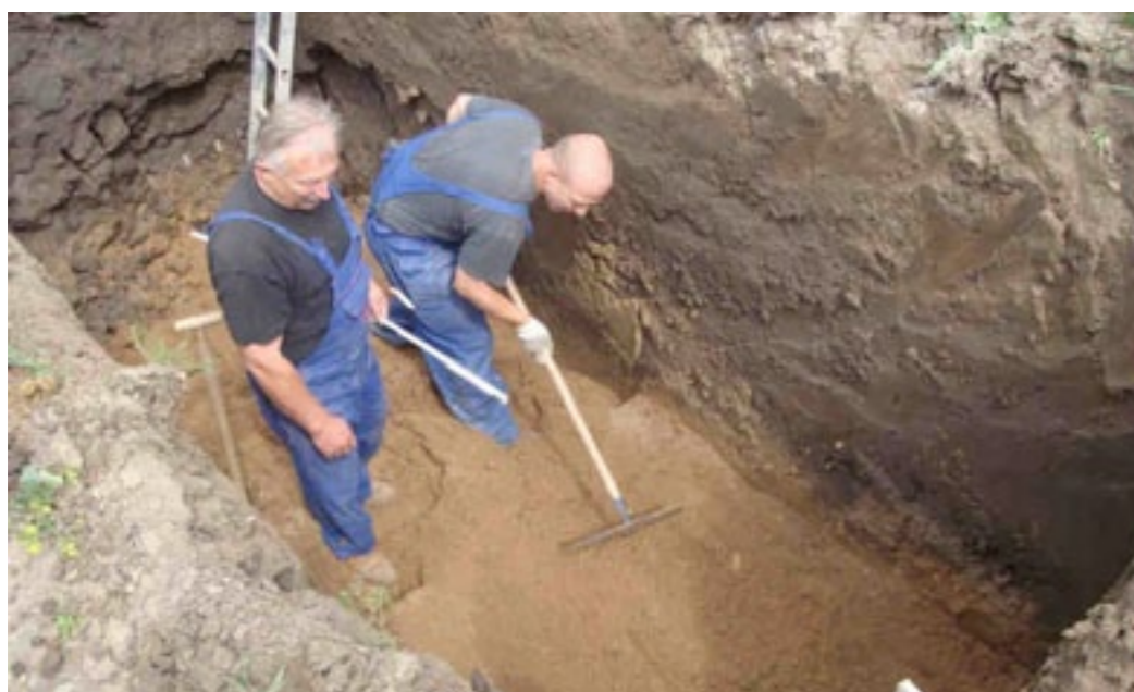
Wyrównywanie dna wykopu
