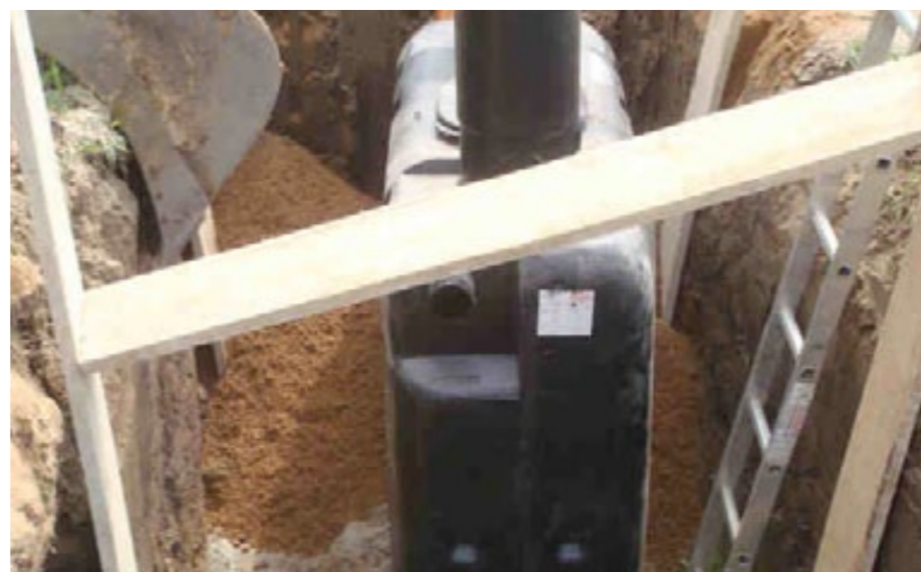
Wypełnianie wykopu budowlanego
