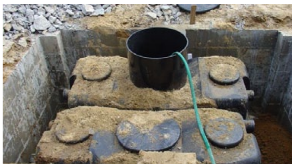
Rozwiązanie niestandardowe – zbiornik w wykopie murowanym dla gruntów niekorzystnych
