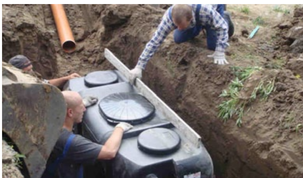
Poziomowanie osadnika gnilnego we właściwym położeniu
