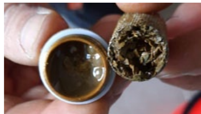
9 Osady korozji elementów stalowych instalacji c.o. wyłapanie przez filtr siatkowy
