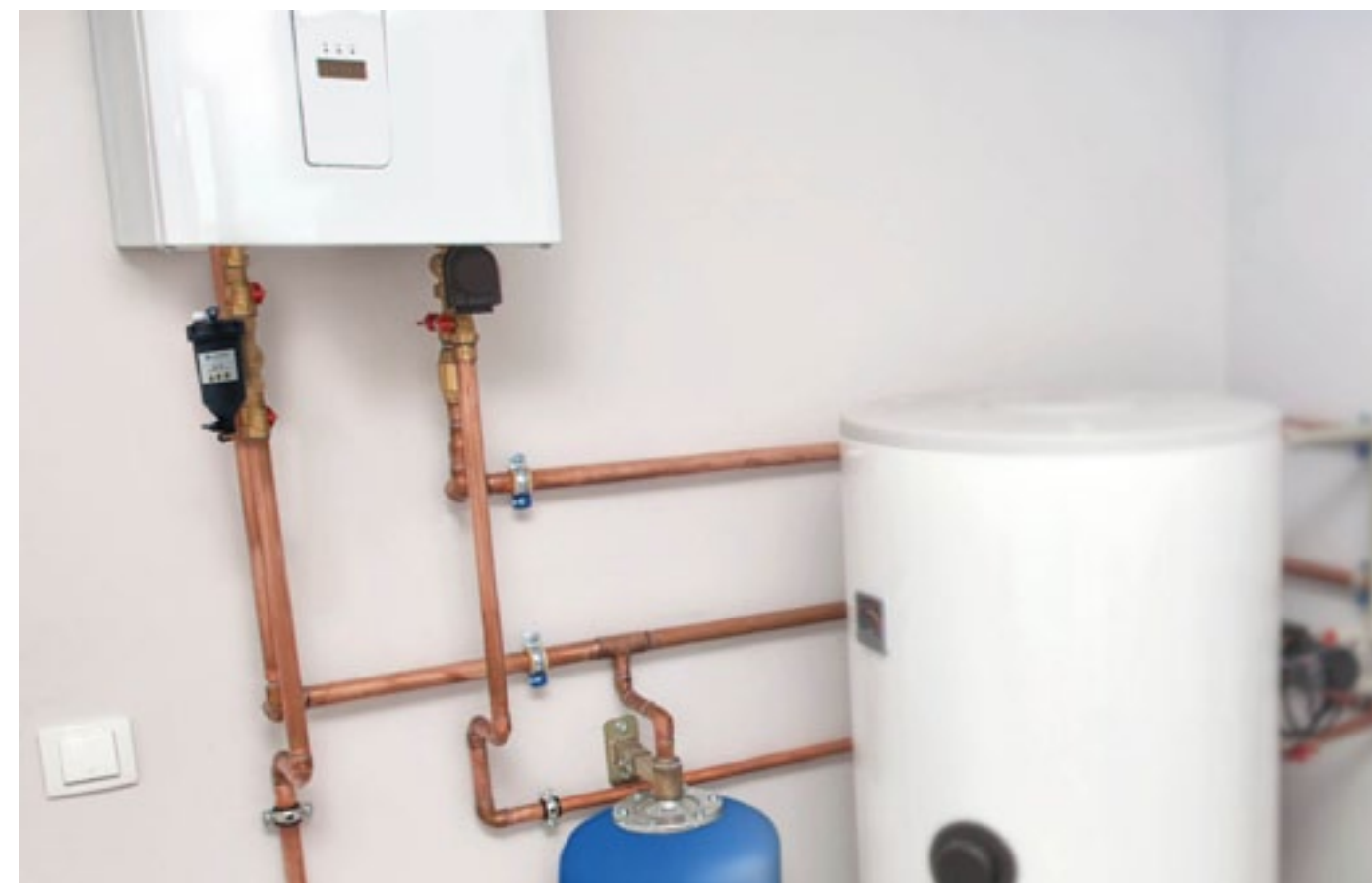
Przykład montażu separatora ADS 160 w kotłowni z pompą ciepła
