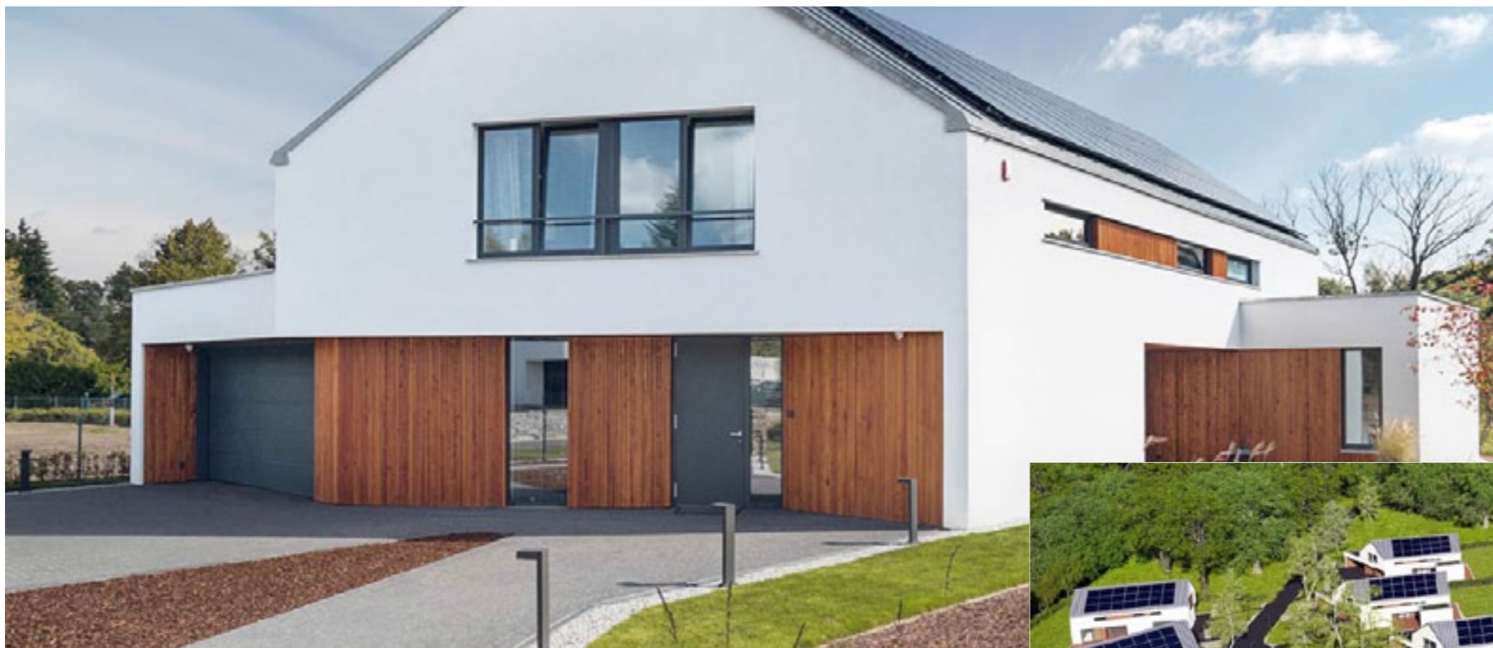
Dom jednorodzinny z zamontowanym SYSTEMEM M
