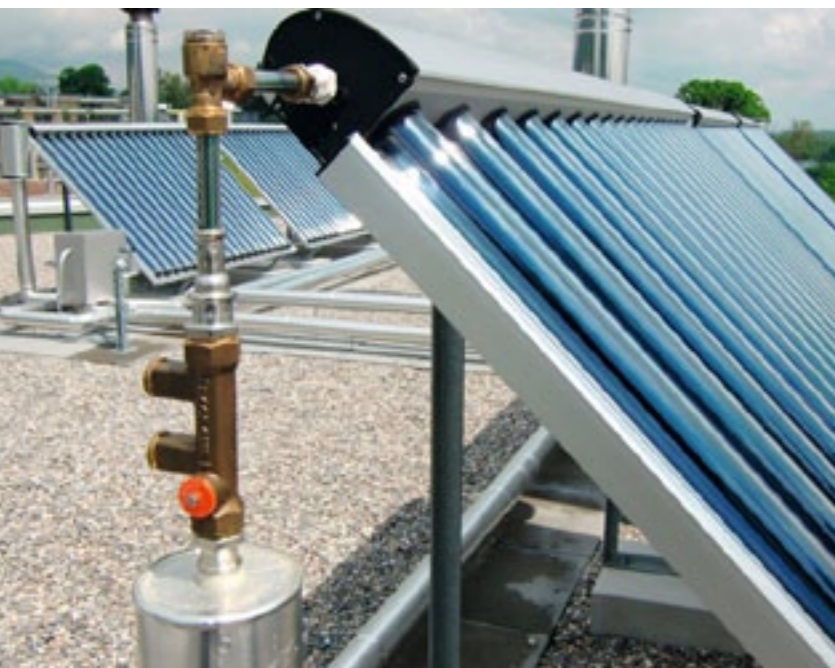
Setter BP Solar – montaż na instalacji
