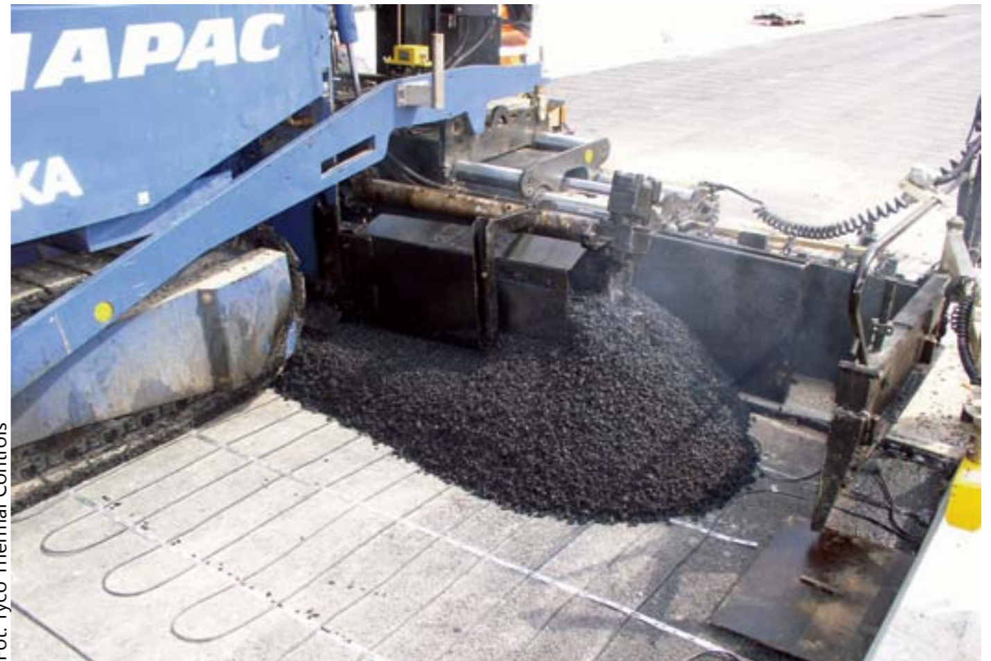
Układanie przewodów grzewczych EM2-MI w gorącym asfalcie
