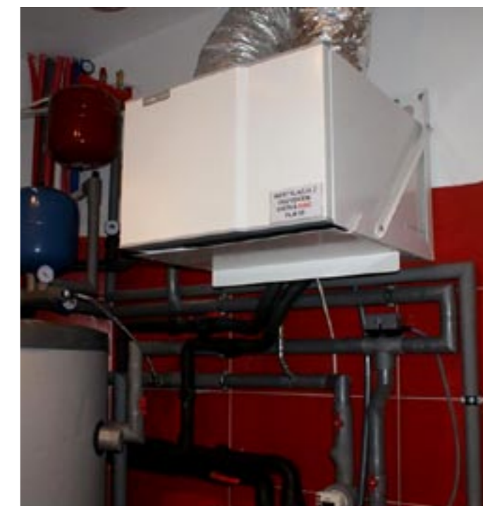
Moduł wentylacyjny FLM 30 współpracujący z gruntową pompą ciepła NIBE F1150
