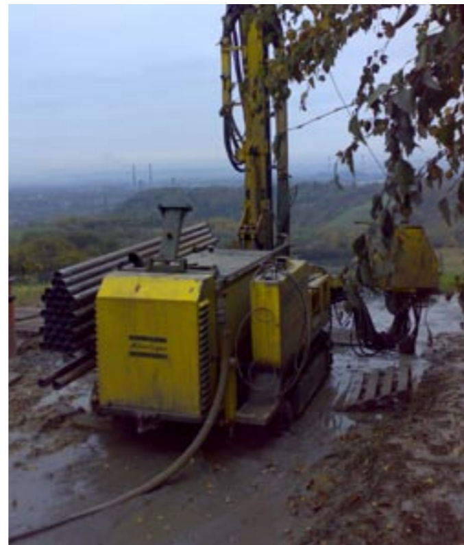
Wygląd placu budowy podczas wiercenia otworów pod sondy i... wizja przyszłego pomieszczenia technicznego z pompą ciepła – kontrast duży, ale wszystko to tylko kwestia czasu
