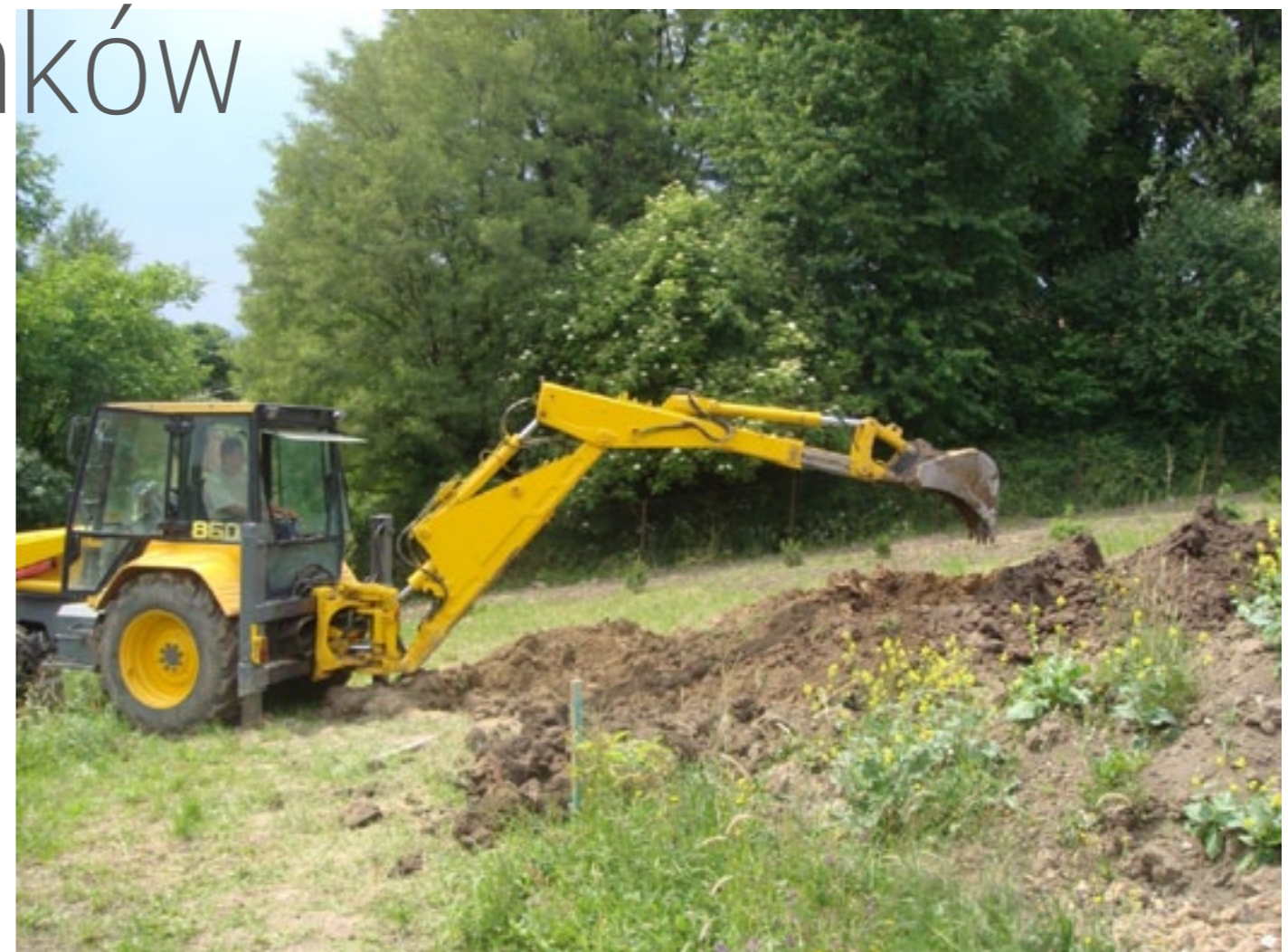
Wykop pod przydomową oczyszczalnię
