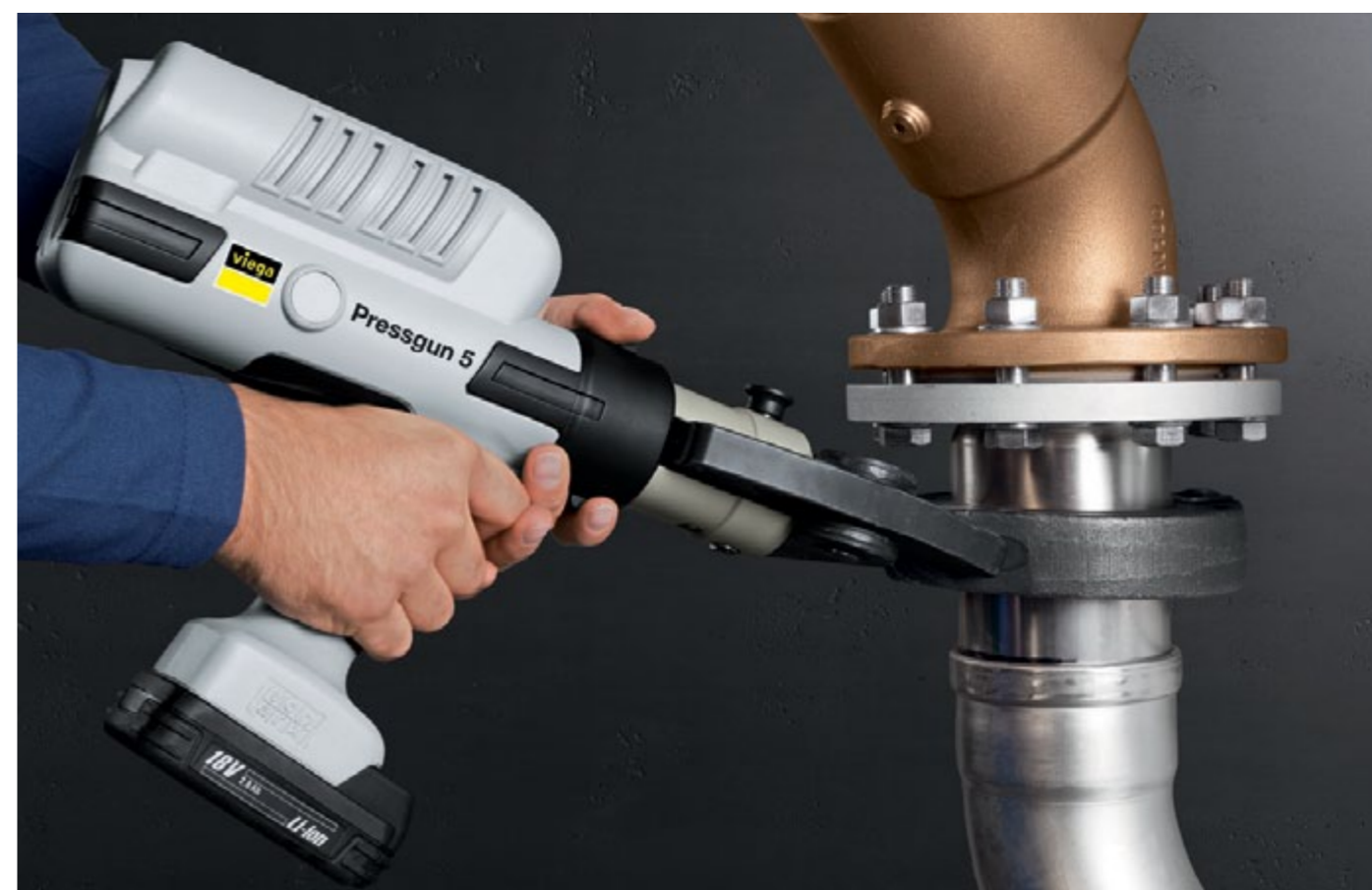
Połączenia zaprasowane kształtek XL wykonuje się za pomocą zaciskarek ze szczękami przegubowymi
