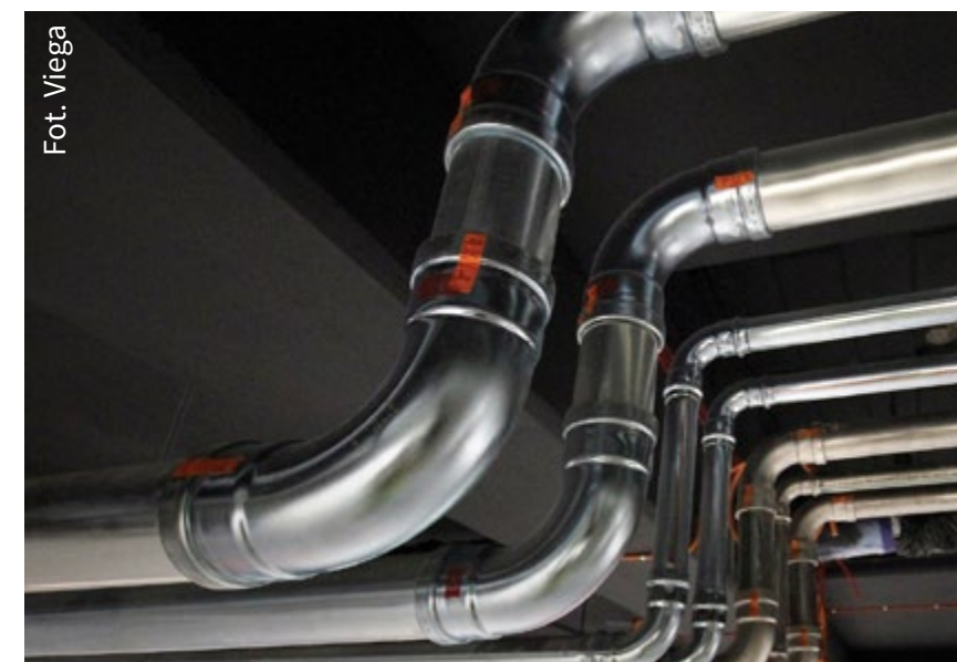
Fragmety instalacji w systemach Prestabo (na pierwszym planie) i Sanpress Inox
