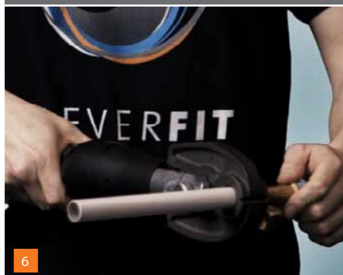
Zaprasowanie połączenia
