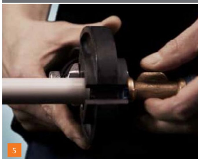
Dopasowanie złączki do szczęki typu TH lub U
