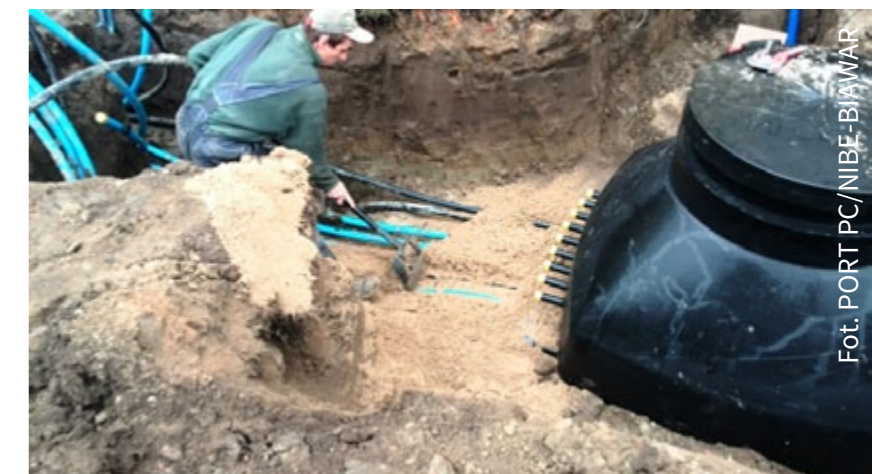
4 Prace przy wykonaniu dolnego źródła ciepła
