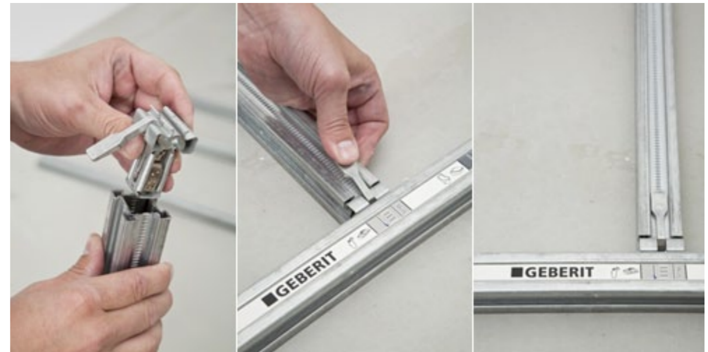
Łączenie profili nie wymaga żadnych narzędzi
