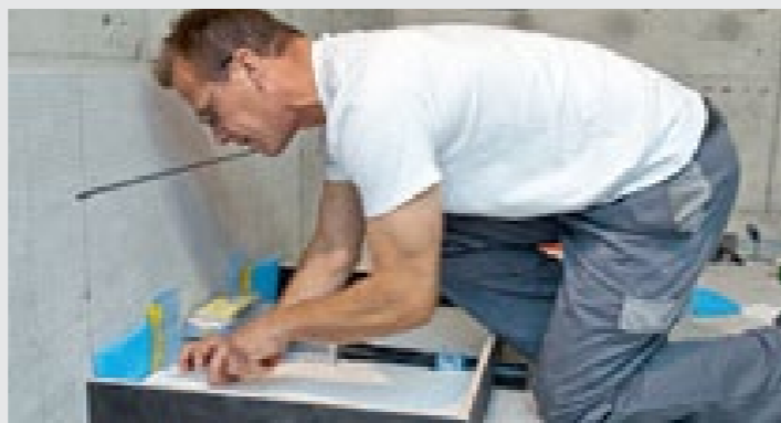
Prostokątny kształt układu syfonowego ułatwia integrację całego urządzenia z materiałami izolacyjnymi w podłodze
