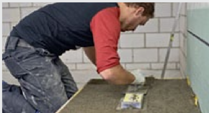
Stworzenie stałego pochylenia podłogi
