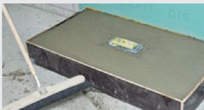
„Plac budowy” gotowy na rozpoczęcie prac glazurnika. Kołnierz odpływu z wtryskiwaną folią uszczelniającą nadal zaplombowany
