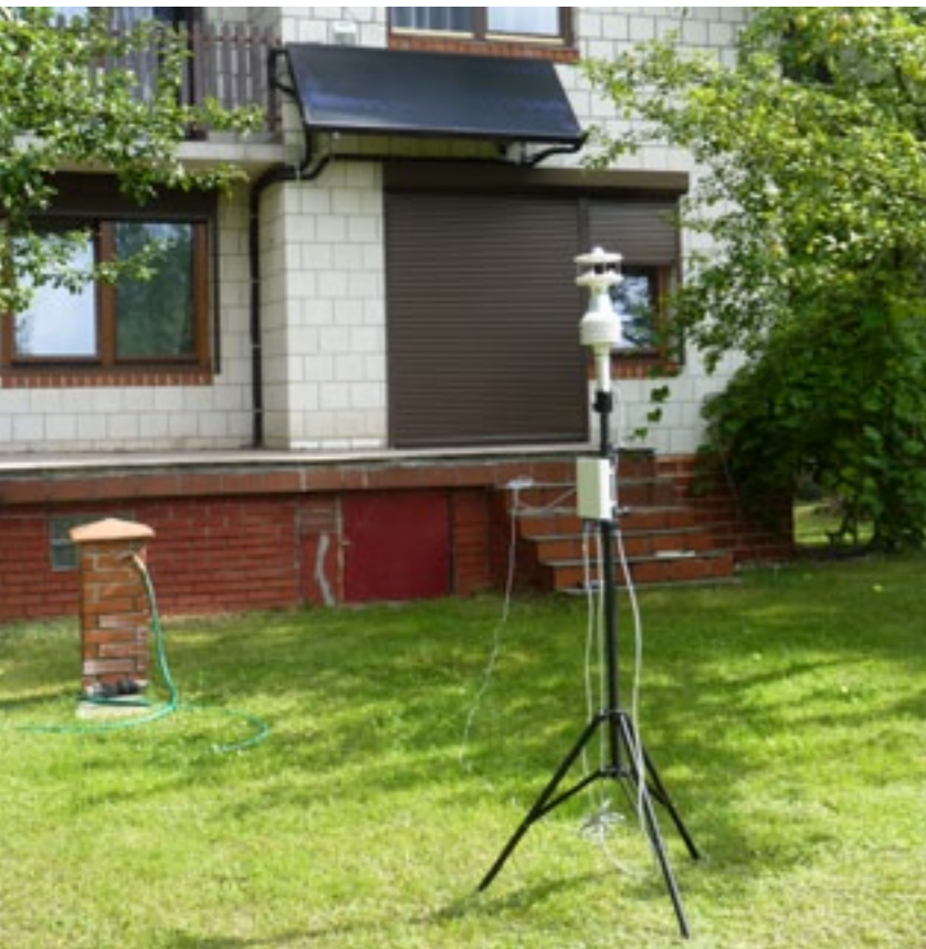
1 Badany obiekt ze stacją meteorologiczną
