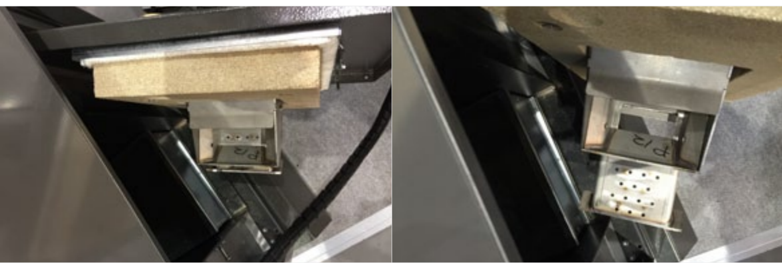
Ruchome części automatycznie czyszczonego palnika w kotle peletowym firmy Nibe
