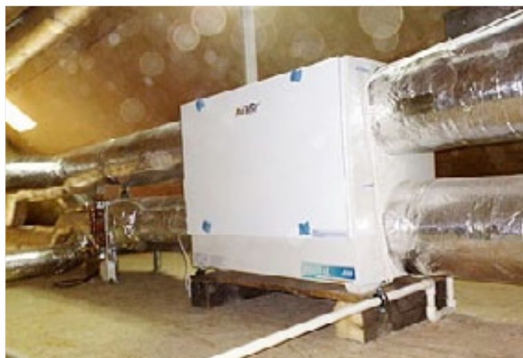
Jankowice – dom prywatny, instalacja wentylacji mechanicznej z zastosowaniem rekuperatora umiejscowionego na poddaszu
