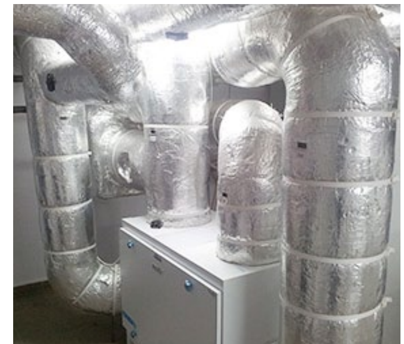
Montaż rekuperatora (wykonany przez firmę WAREBUD)
