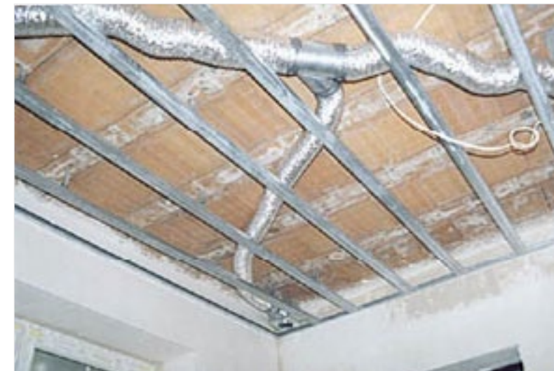
Rozprowadzenie kanałów ocieplonych i wygłuszonych w suficie podwieszanym
