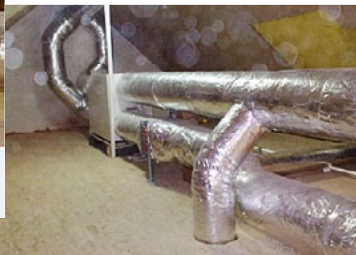
Jankowice – dom prywatny, instalacja wentylacji mechanicznej z zastosowaniem rekuperatora umiejscowionego na poddaszu
