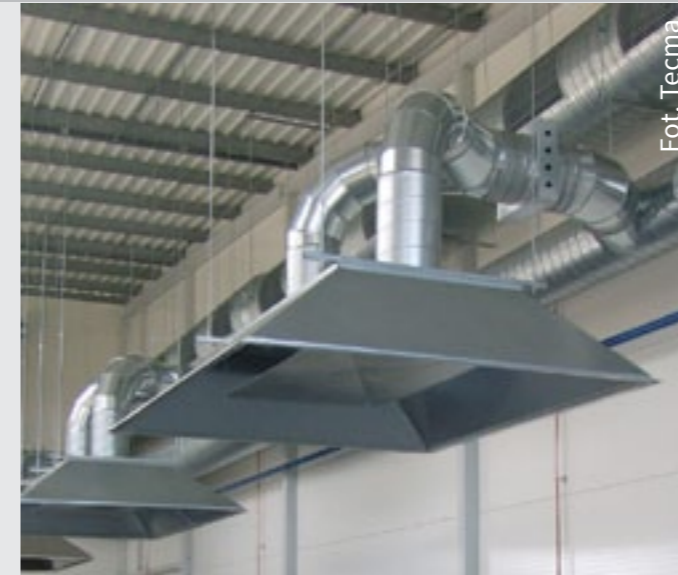
Przyłączenie okapów (nad robotami spawalniczymi) do instalacji centralnej
