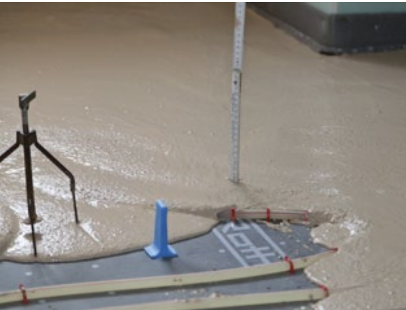
Wylewanie jastrychu w systemie QE
