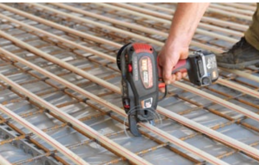
Mocowanie rury do zbrojenia w ogrzewaniu przemysłowym
