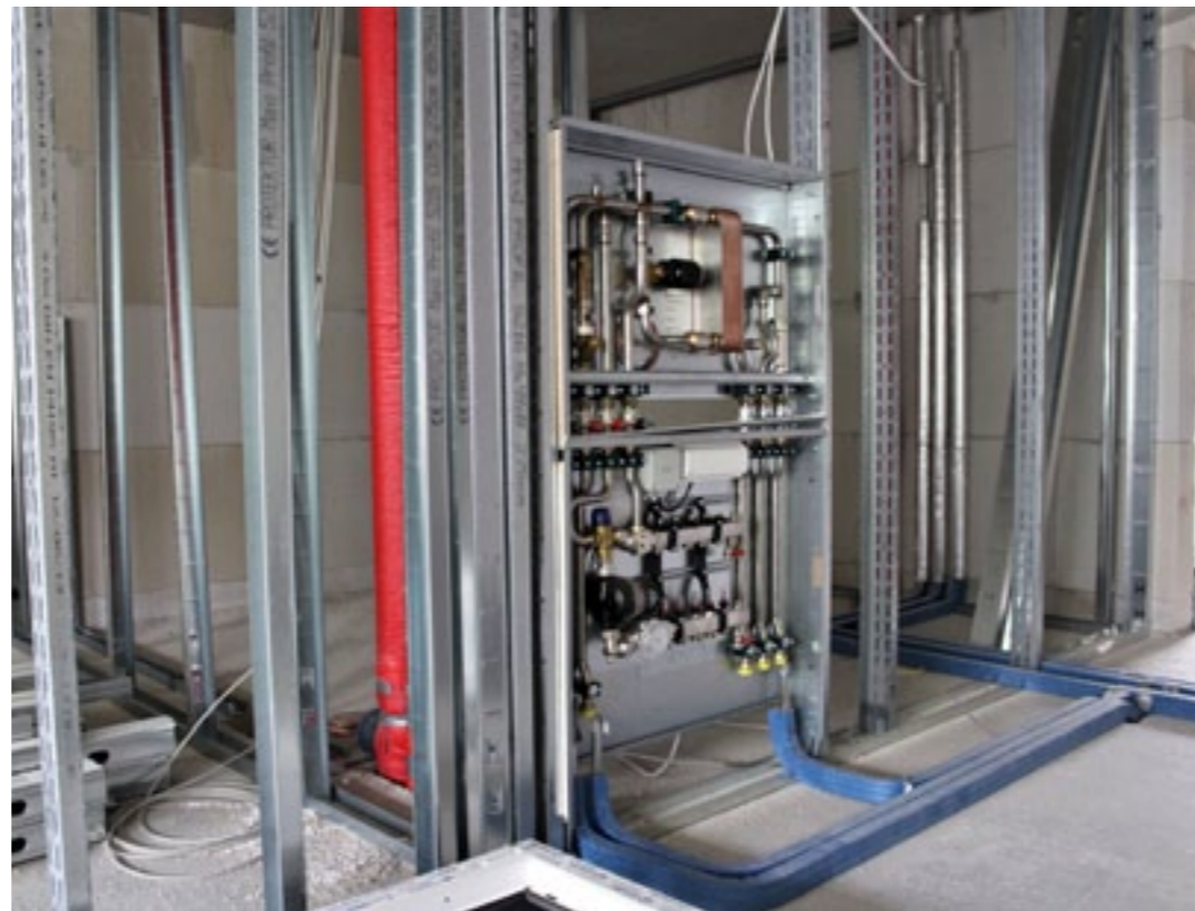
Mieszkaniowe węzły ciepłe oznaczają zainstalowanie w jednostce mieszkaniowej wszystkich elementów regulacji i armatury odcinającej, jak również liczników ciepła i wody w centralnym punkcie kompaktowej jednostki systemowej
