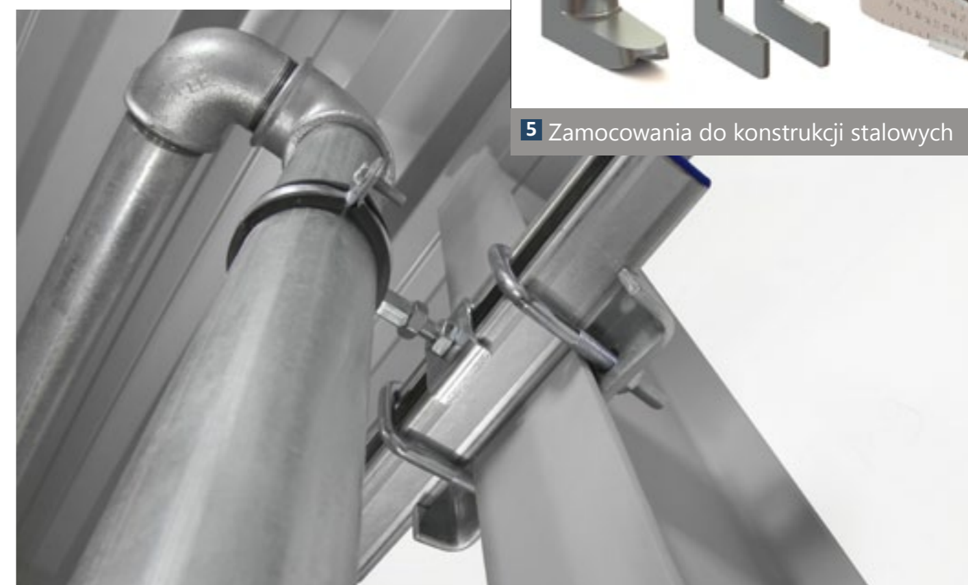
4 Podwieszenie rurociągów do konstrukcji stalowej z zastosowaniem elementów montażowo-łączących Niczuk Metall-PL (klamry do profili hutniczych KLM)
