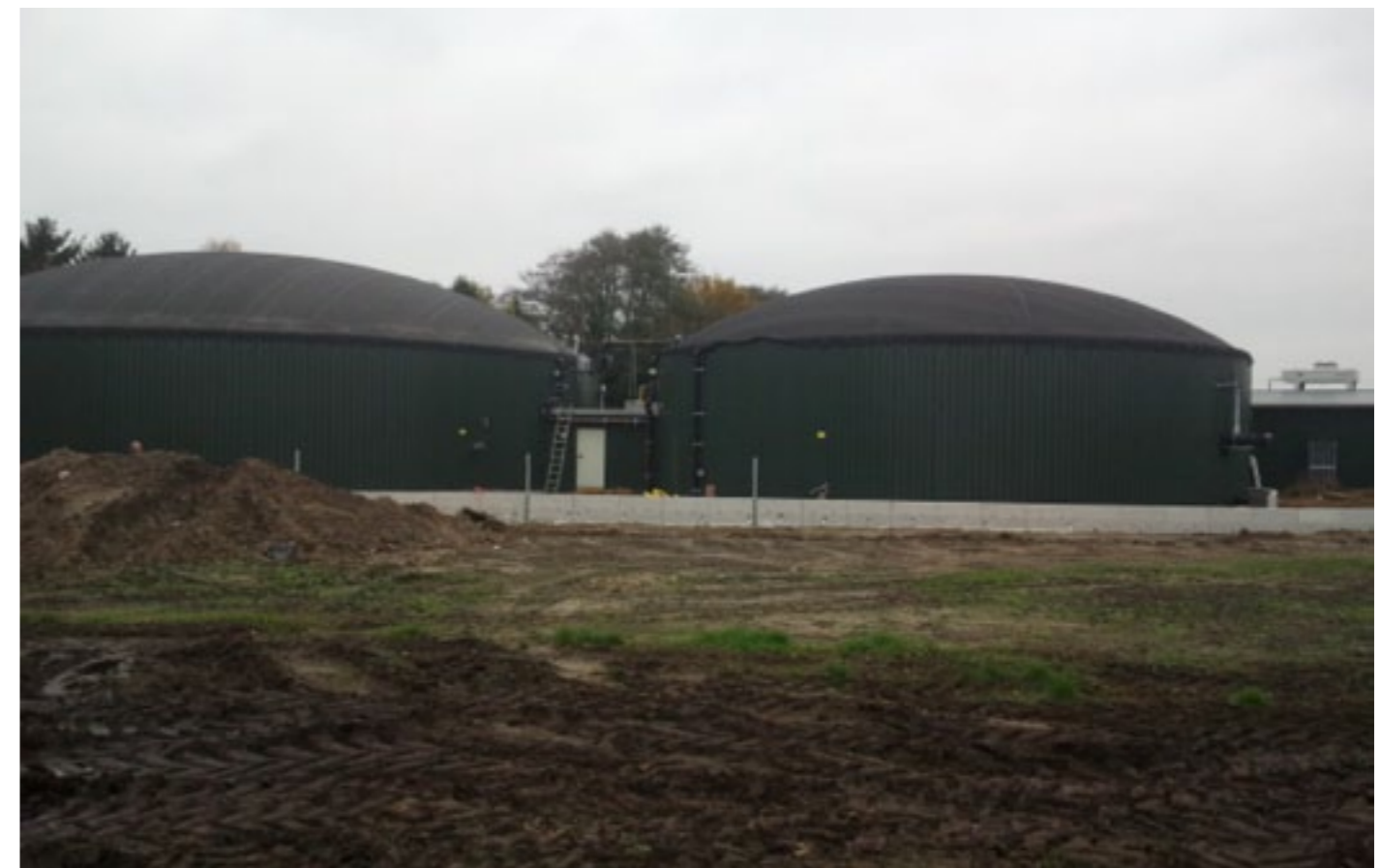
Biogazownia w Ottenhagen w Dolnej Saksonii
