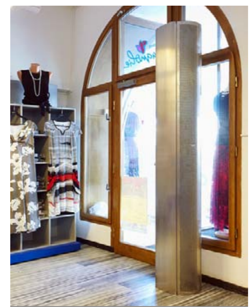
Kurtyna TUBEX w obudowie ze szczotkowanej stali nierdzewnej. Przyłącza hydrauliczne oraz elektryczne poprowadzone od dołu urządzenia, zawory regulacyjne standardowo wbudowane w urządzenia
