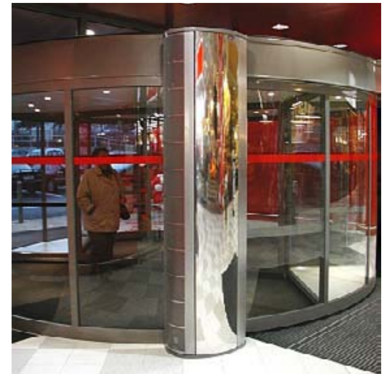
Kurtyna ARCUS specjalistyczne urządzenie do drzwi obrotowych, obudowa z polerowanej stali nierdzewnej. Przyłącza hydrauliczne oraz elektryczne poprowadzone od dołu urządzenia, zawory regulacyjne standardowo wbudowane w urządzenie. Praca urządzenia uzależniona od ruchu drzwi obrotowych
