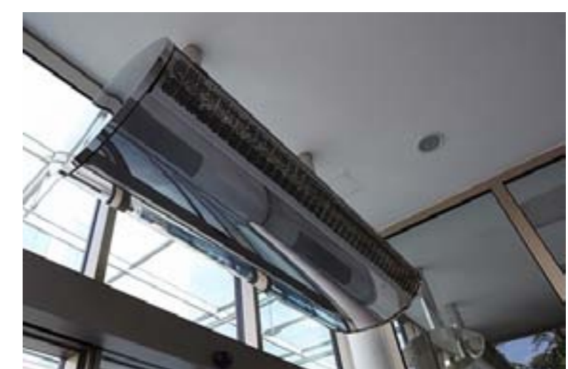
Kurtyna NUCLEO 3000 – z polerowanej stali nierdzewnej. Uchwyty montażowe pozwalają na ukrycie wszystkich instalacji i przewodów połączeniowych. Zawory standardowo są wbudowane w urządzenie
