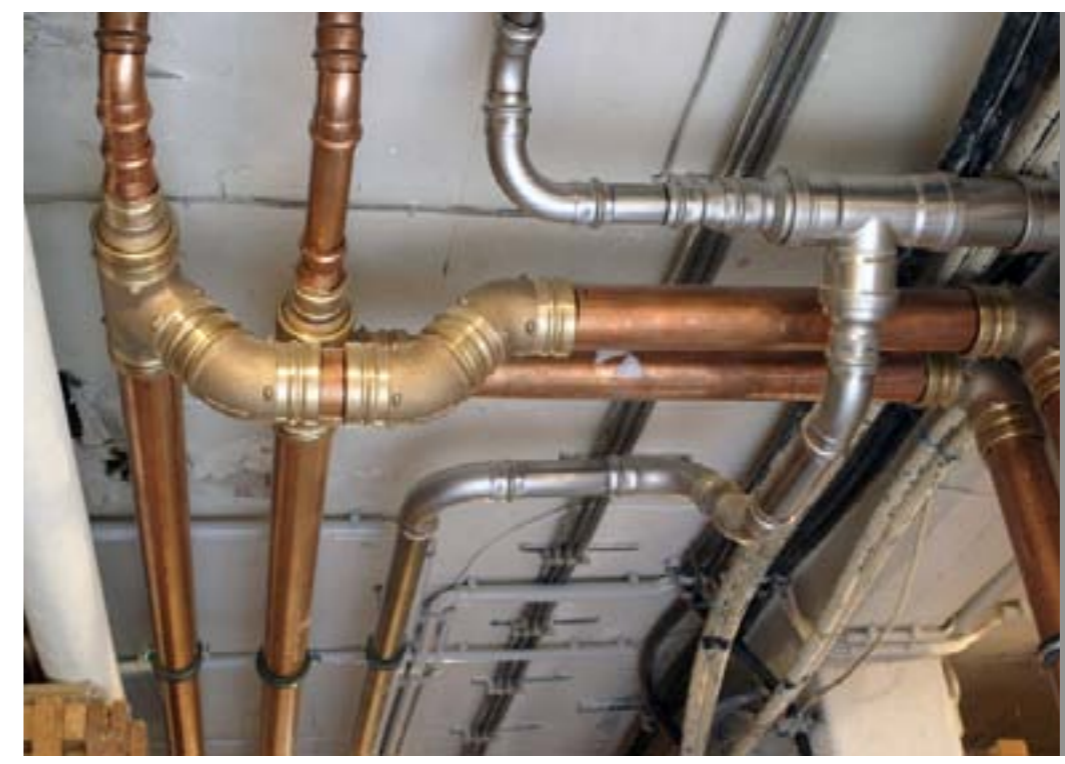
Rury o średnicy znamionowej DN 64 idealnie sprawdzają się jako przewody rozdzielcze w instalacjach wody użytkowej i pozwalają na wykonanie instalacji o wymiarach odpowiednich do potrzeb. Zastosowanie rur o następnym szeregu średnicy znamionowej (76 mm) może spowodować przewymiarowanie instalacji
