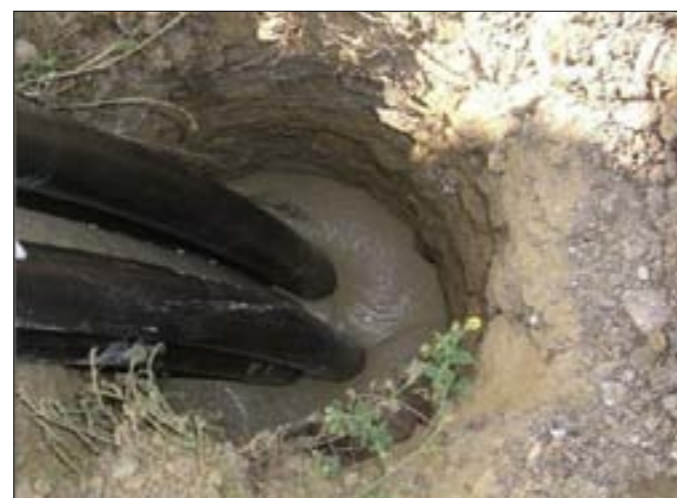
3 Wypełnienie otworu wiertniczego dedykowanym materiałem wypełniającym
