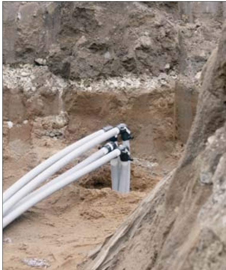
5 Podłączenie sondy pionowej do rur dobiegowych
