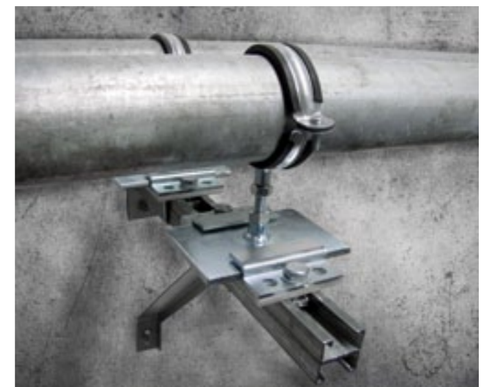
5 Montaż podpór ślizgowych do konstrukcji z profili montażowych
