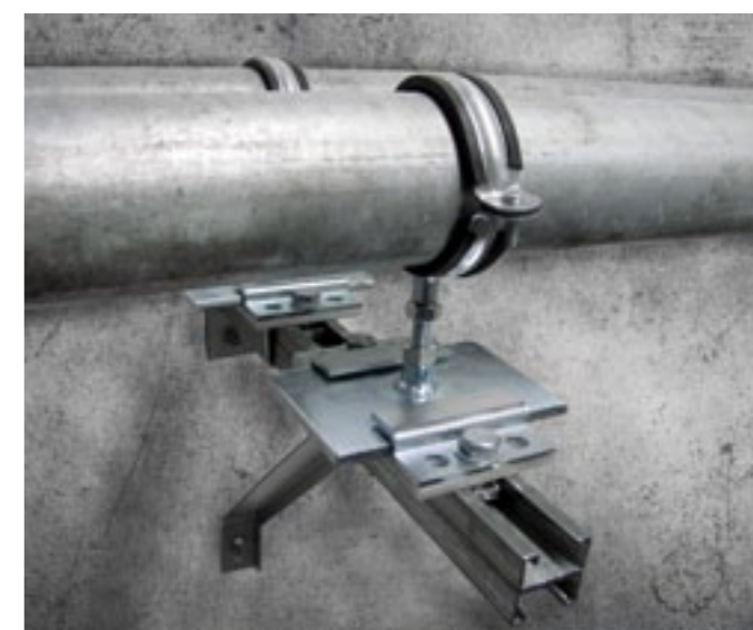
5 Montaż podpór ślizgowych do konstrukcji z profili montażowych
