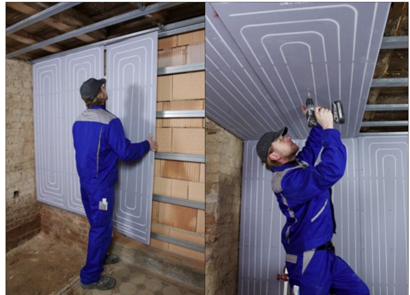
Montaż suchej zabudowy Renovis; linie pokazujące układ rur w płytach Renovis ułatwiają montaż oświetlenia oraz kratki wentylacyjnych
