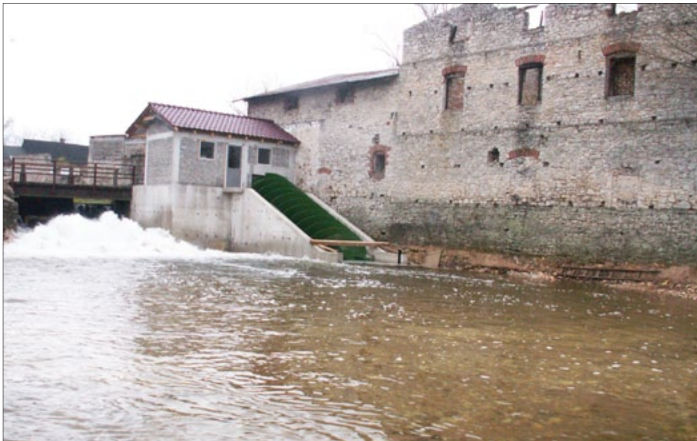
Widok na elektrownię wraz z jazem od strony wody dolnej
