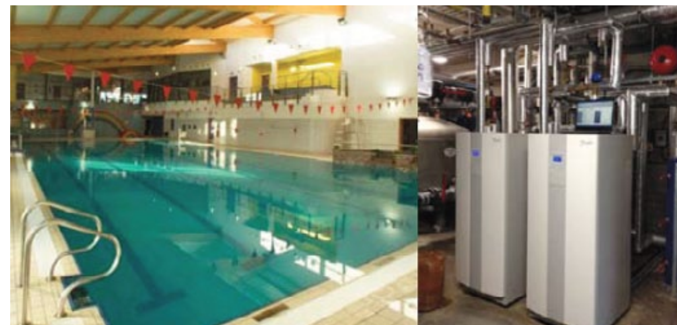
Przykładowa instalacja: Centrum Sportowe Monaghan w Irlandii, dwie pompy DHP-R 42 kW
