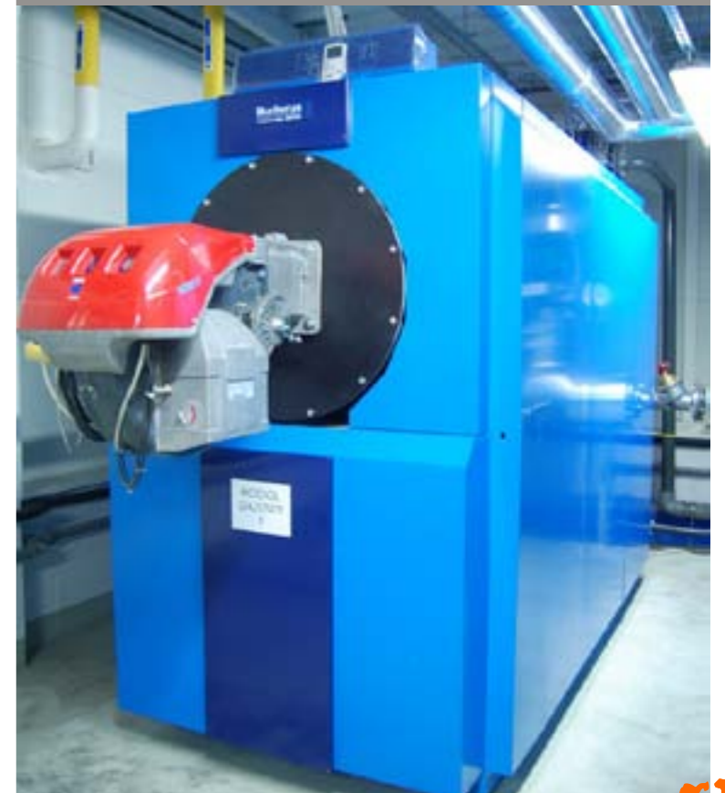
Dzięki zamontowanemu w kotłach modułowi Lon Geatwey urządzenia współpracują z wewnętrznym systemem zarządzania całym budynkiem BMS
