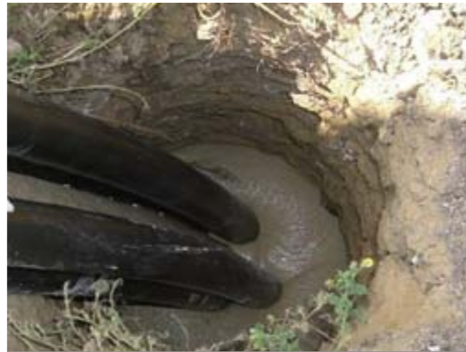
5 Wypełniony odwiert z sondą pionową
