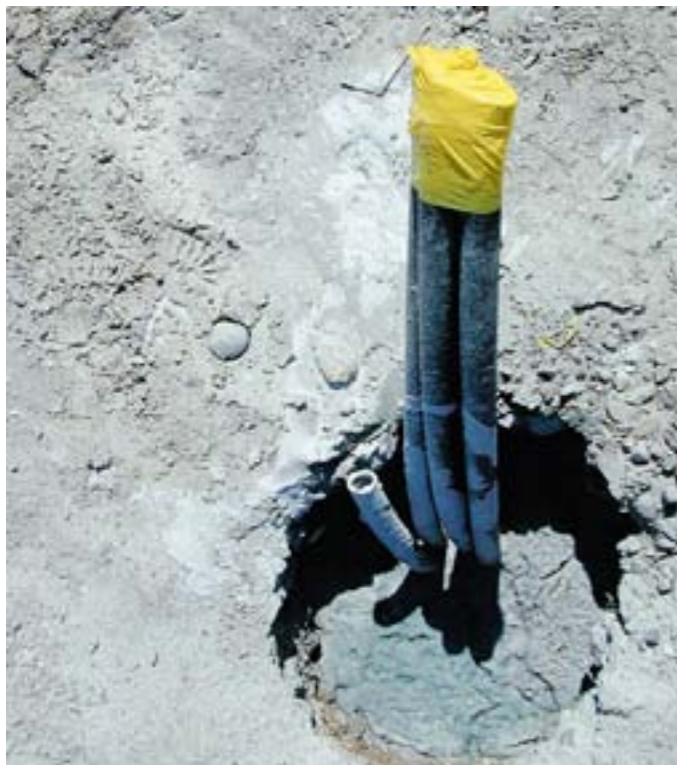
4 Na wylocie wierconego otworu należy zwrócić uwagę na to, aby zawieszona posiadała wymaganą gęstość
