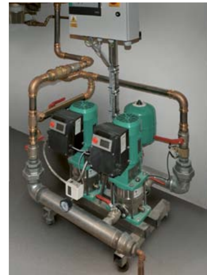
Podłączenie do zestawu hydroforowego
