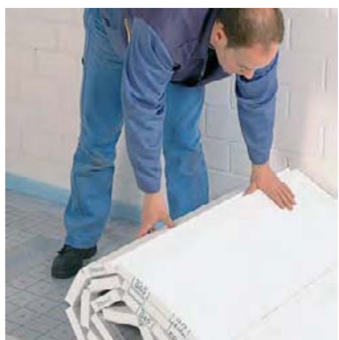
Rozkładanie izolacyjnej płyty systemowej 35-3 z rolki
