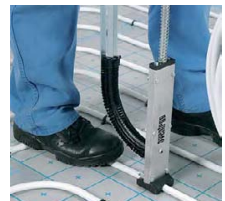
Rysunek siatki rastru ułatwia pracę monterom instalacji mocującym rury do płyty za pomocą narzędzi Oventrop
