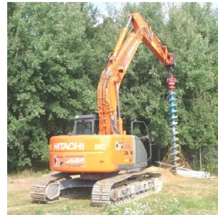
Urządzenie do wykonania odwiertów na pionowe sondy geotermalne w kształcie spirali
