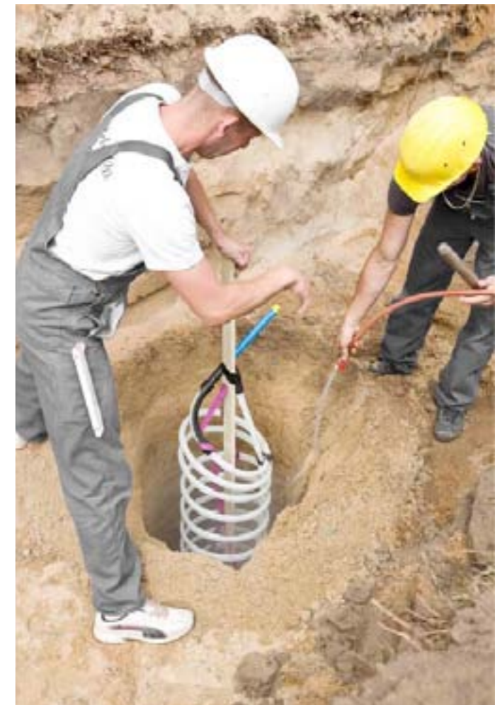
Szybki i łatwy montaż sondy spiralnej z PE-Xa
