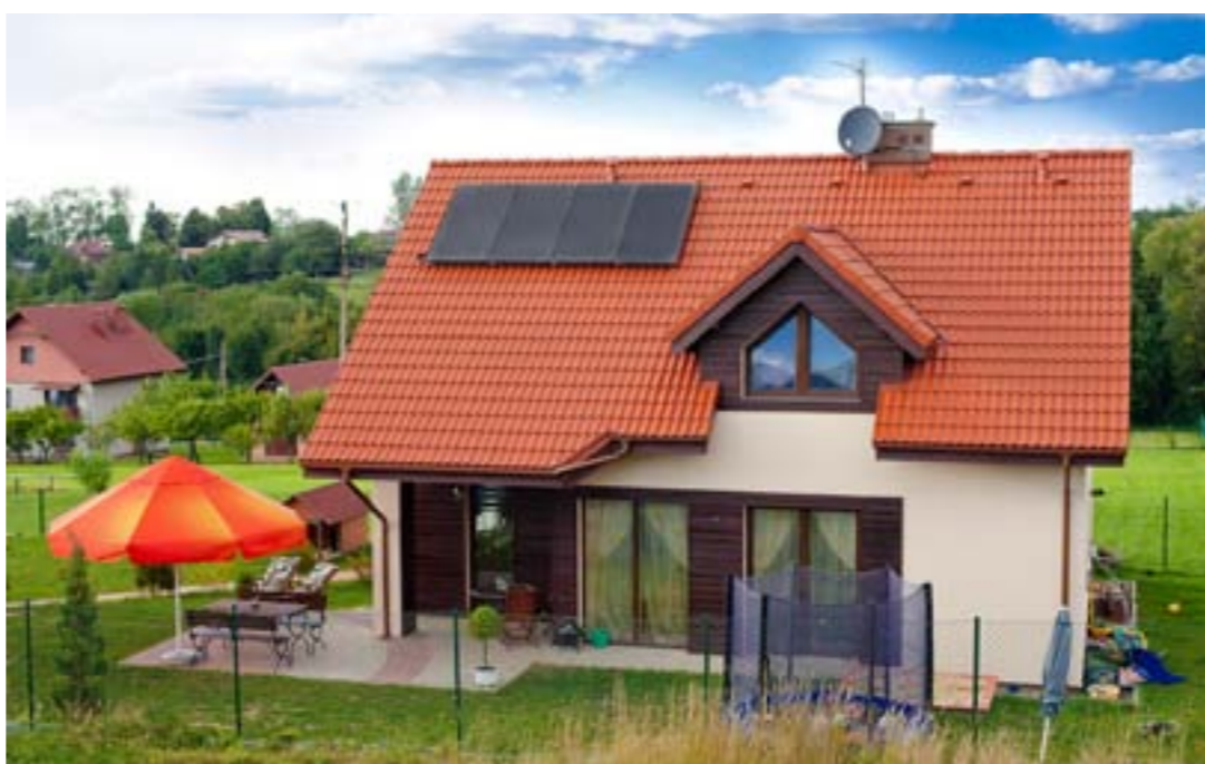
Przykład instalacji solarnej wspomagającej ogrzewanie domu
