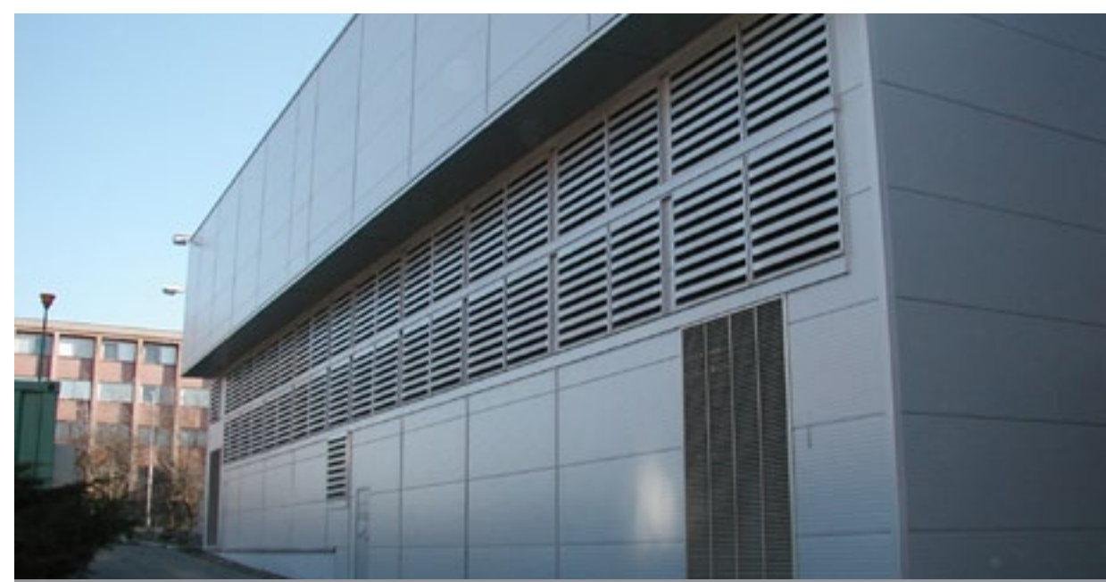
Budynek szpitalny w miejscowości Leipzig w Niemczech z urządzeniami tłumiącymi STAVOKLIMA
