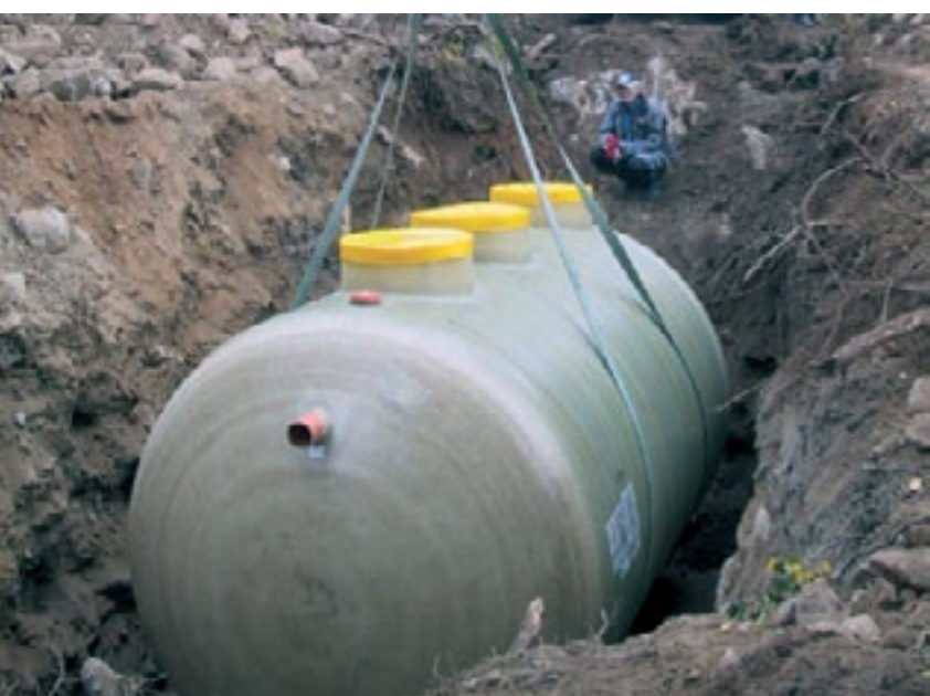
3 W przypadku BioKem 20...90 stosuje się zbiornik wykonany z GRP – laminatu poliestrowego wzmocnianego włóknem szklanym
