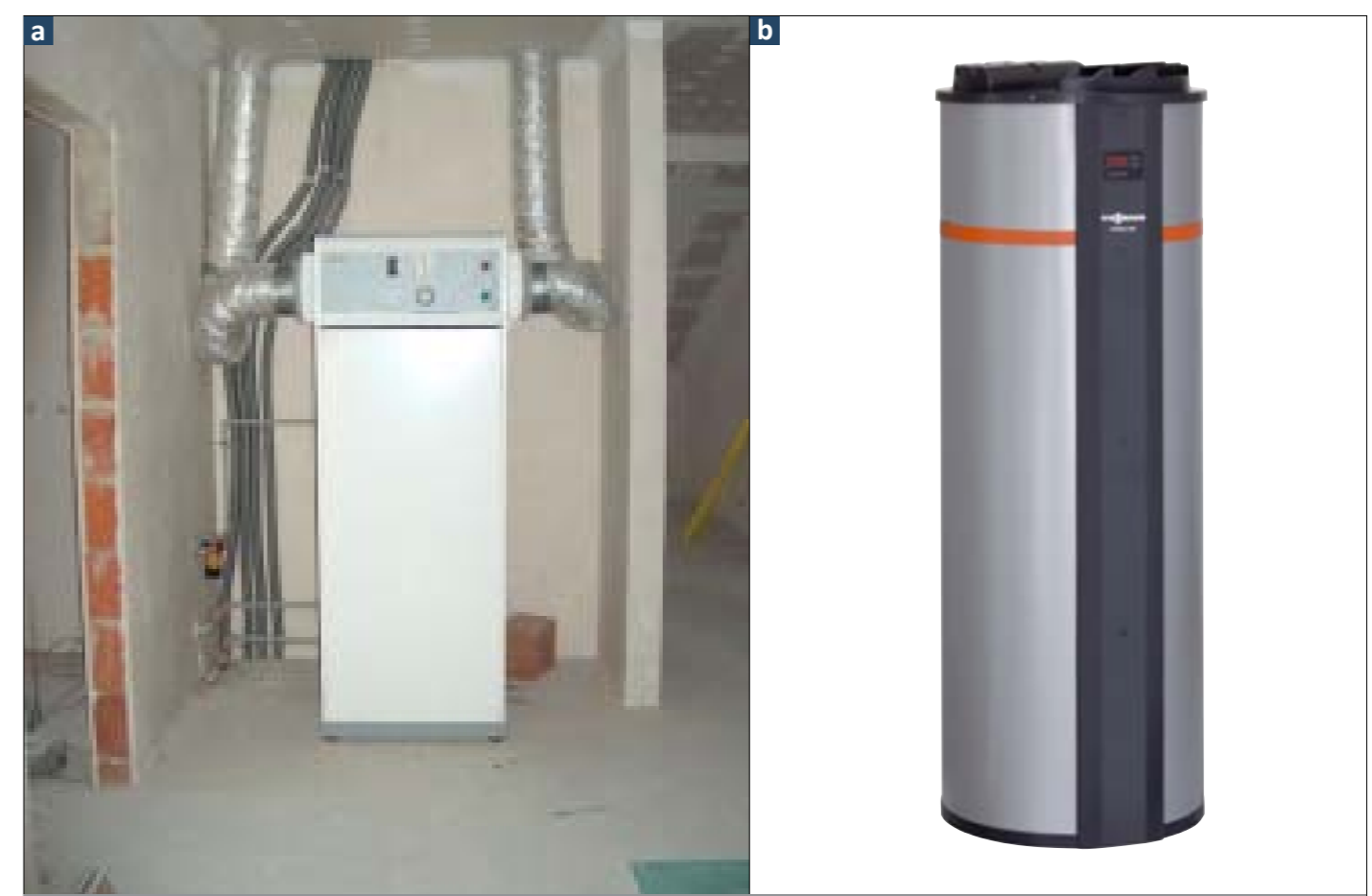
4 a pompa ciepła przystosowana do podłączenia kanałów doprowadzających powietrze Stiebel Eltron WWK 300 b pompa ciepła Viessmann Vitocal 160 A na powietrze obiegowe
