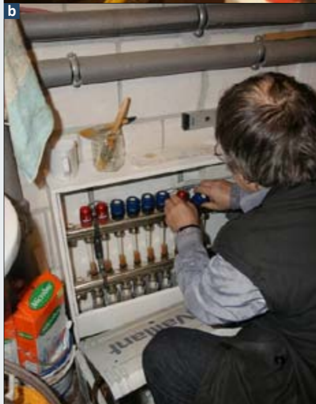
4 Kolejne fazy płukania instalacji: a widok zbiornika urządzenia płuczącego wypełnionego roztworem płuczącym DS40, b przełączanie poszczególnych obiegów grzewczych do płukania instalacji
