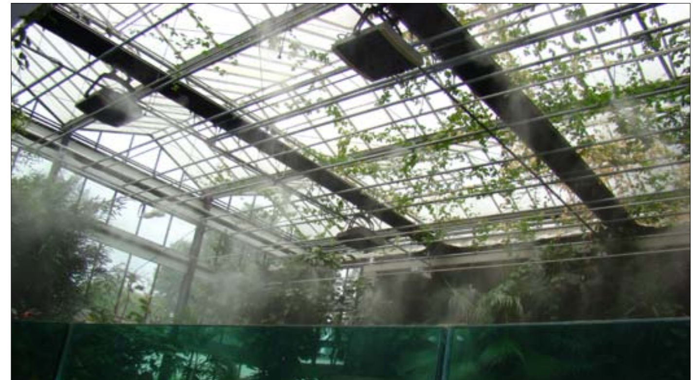
Aby zapewnić wilgotność 80% w hali tropikalnej, konieczne jest zamgławianie za pomocą systemu zraszającego
