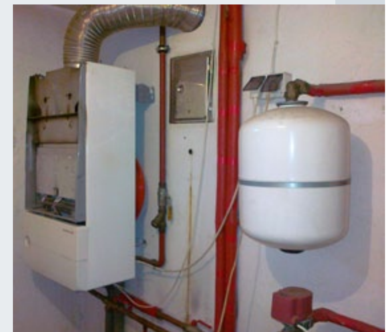
Stary kocioł dwufunkcyjny z otwartą komorą spalania. Kolejne urządzenie w złym stanie technicznym
