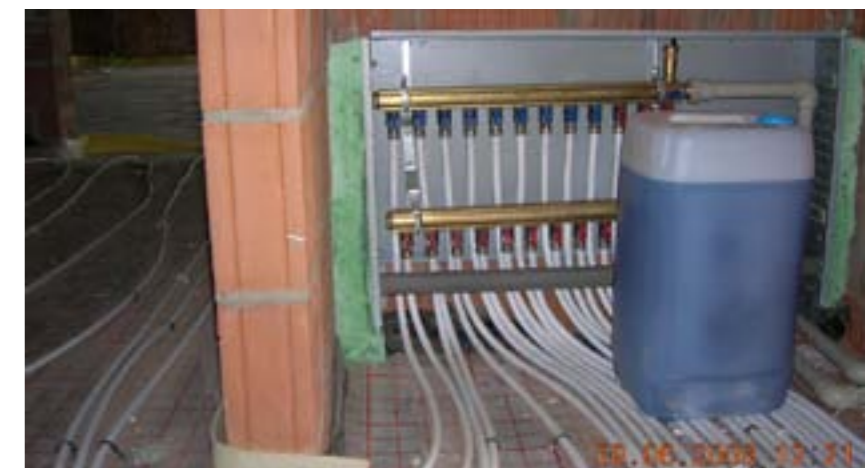
Rys. 5 Rozdzielacz do grzejników
