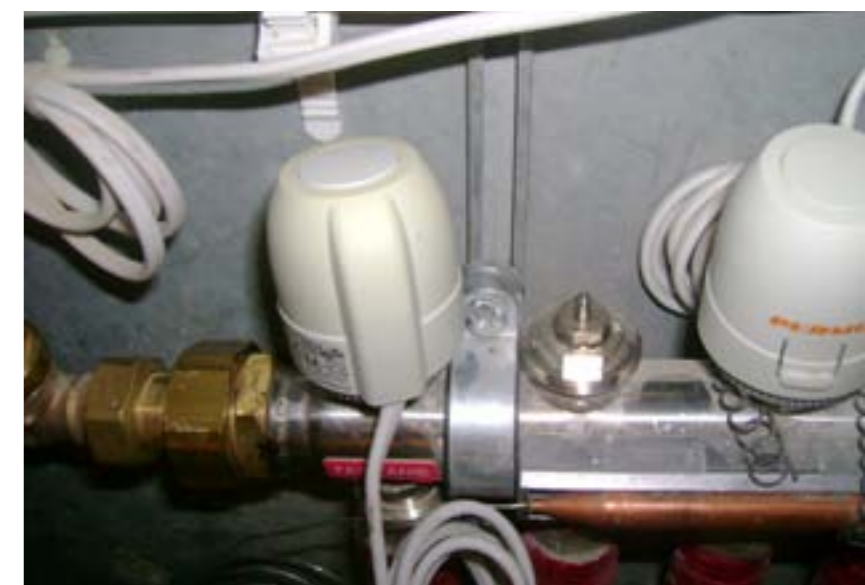
Rys. 6 Wygląd wkładki termostatycznej na rozdzielaczu
