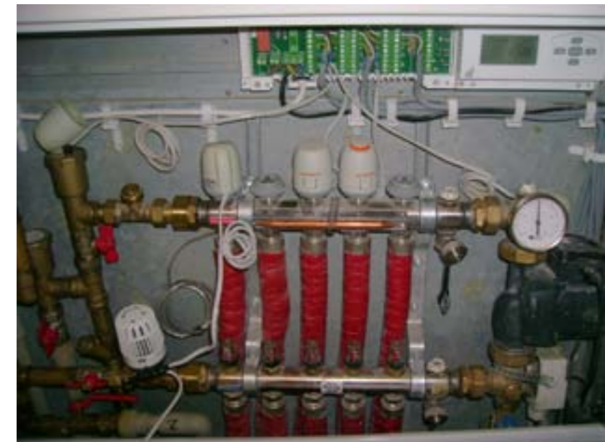
Rys. 4 Rozdzielacz do podłogówki wraz z zestawem mieszającym
