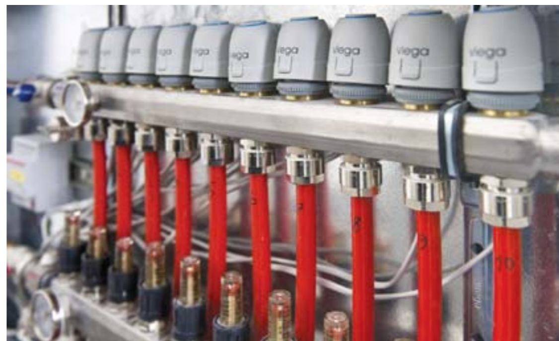
We wszystkich willach zainstalowano kompletny system ogrzewania podłogowego firmy Viega, łącznie z rozdzielaczami
