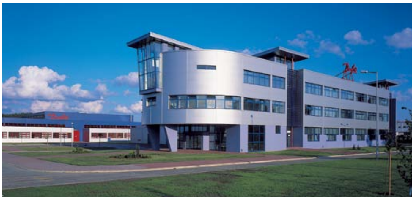
Siedziba firmy Danfoss Poland Sp. z o.o. w Grodzisku Mazowieckim
